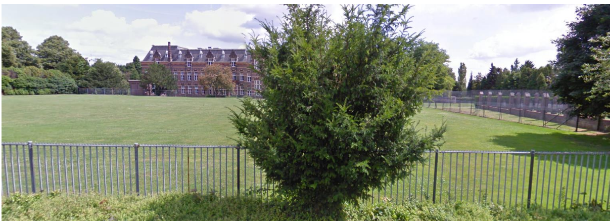
Figuur 10. Zicht op de westgevel van het klooster, met rechts op de foto het ommuurde begraafplaatsje van de Broeders (bron: Google Maps).
